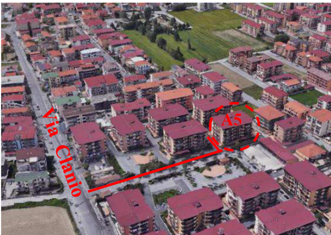
Viste dall'alto del fabbricato A5 di cui l'appartamento e il box auto pertinenziale pignorato sono parte integrante
